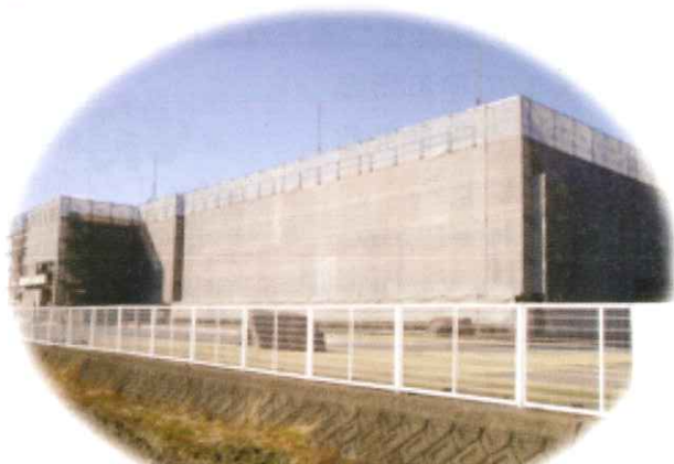
外壁補修時の外部足場状況
