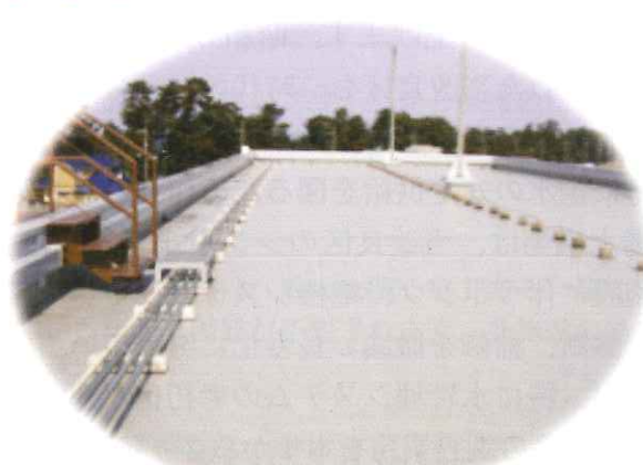
屋上防水改修状況
