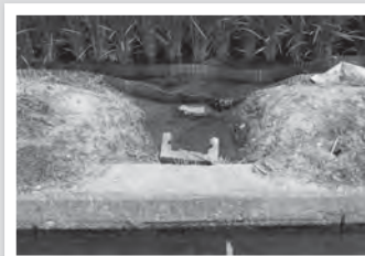
◀戻水戸周辺損傷状況
