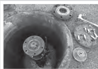
◀空気弁分解清掃
