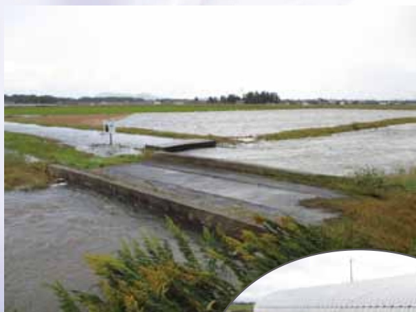
増水により橋や 水管橋が浸水
