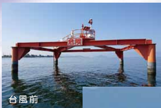
琵琶湖内の取水塔
