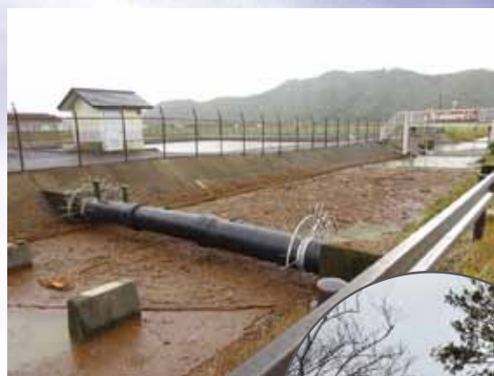
琵琶湖放水路へ大量のゴミや流木が流入
