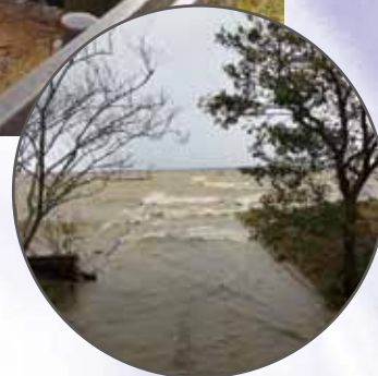
放水路河口状況
