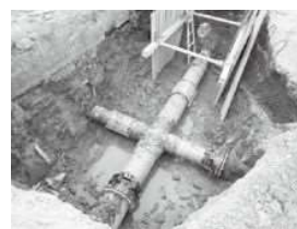
用水管復旧後
