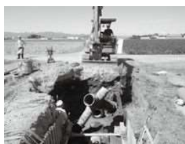
損傷既設管撤去
