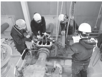
スリーブ隙間測定(整備前)
